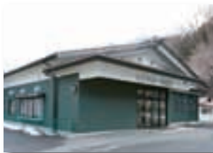
地元業者さんの施設を引き継ぎ改装オープンしたセリオホール釜石。
