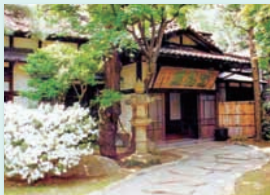
明治18年頃、盛岡出身の実業家瀬川安五郎の邸宅として建てられました。保存を望む多くの声に応えて、いわて生協が保有、維持管理と公開を行っています。
