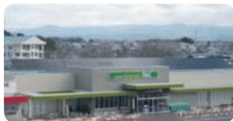
「コープ花巻あうる」屋上には98kWの太陽光発電を設置しました。
