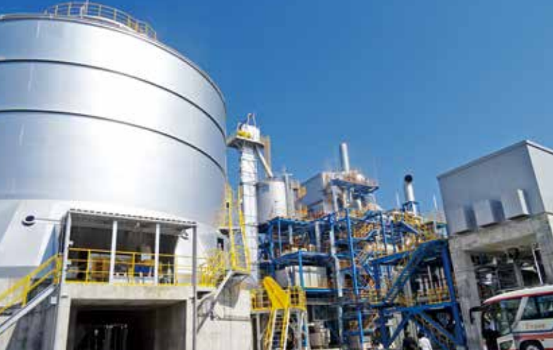
野田木質バイオマス発電。
