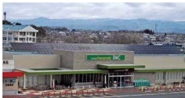
太陽光発電パネルを店舗屋上に設置。
