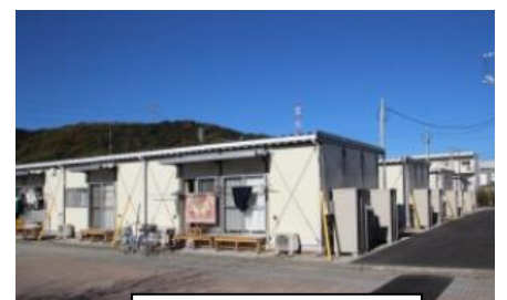
坂町の仮設住宅
