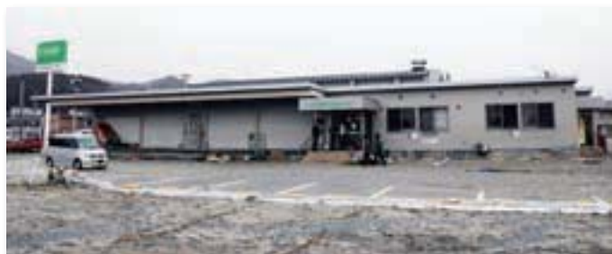
建物は残ったものの設備に大きな被害を受けたけせん支部。
