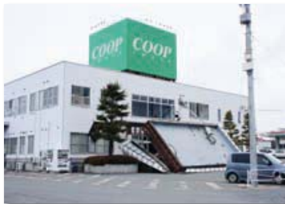
玄関風除室が倒壊した、本部北棟（滝沢村）。
