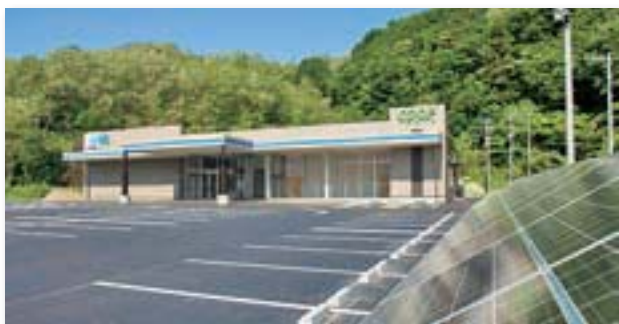
3基目の太陽光発電を装備したセリオホールみやこ。
