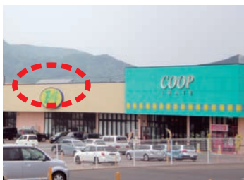
店舗での太陽光発電は、県内流通業で先進的な取り組みです。
