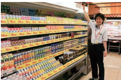
冷却効率を維持するため、冷気の吹き出し口を定期的に清掃。
