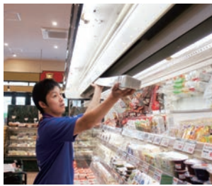
冷却効率を維持するため、冷気の吹き出し口を定期的に清掃。
