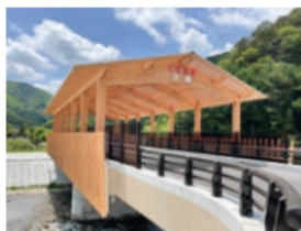
カラマツ材を使った木製屋根の「くずまき大橋」
