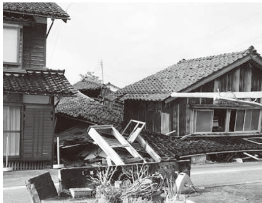
能登町内。地盤や家の耐震性の影響か、倒壊した家と比較的被害が少なかった家が混在している。
