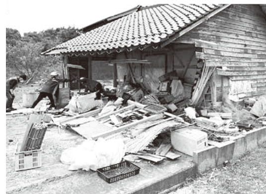
津波被害にあったお宅での活動。自宅の物以外にも津波で流れてきた漁網やゴミなどが散乱していた。
